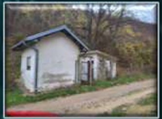
Kaptaža „Bela Voda“ 380 mNv
