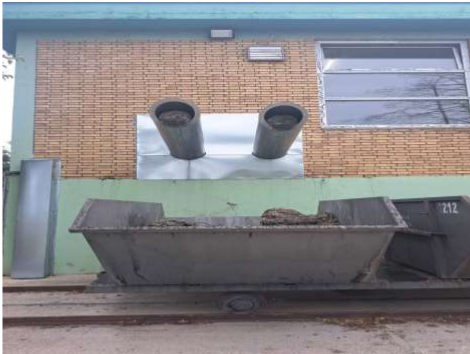
Slika: Prese sa kontejnerima kod finih rešetki
