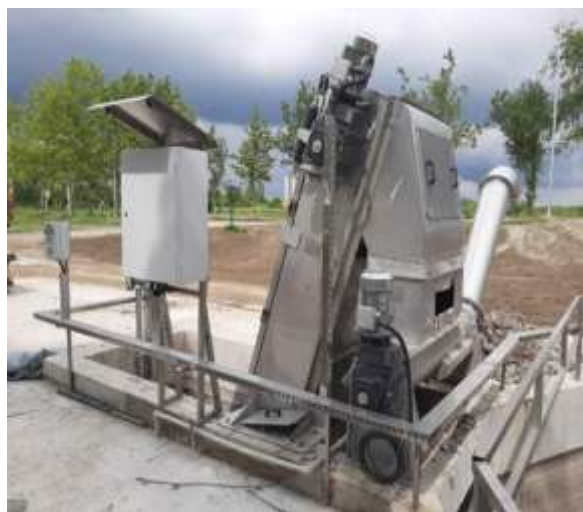
Slika: Gruba rešetka sa presom
