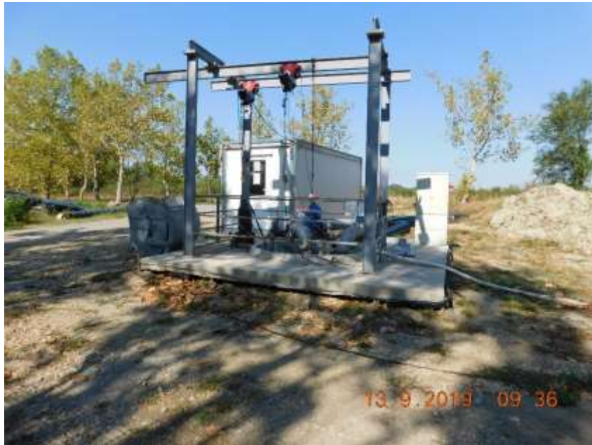
Slika: Ulazna CS privremenog „by-passa“ sa ručnom rešetkom
