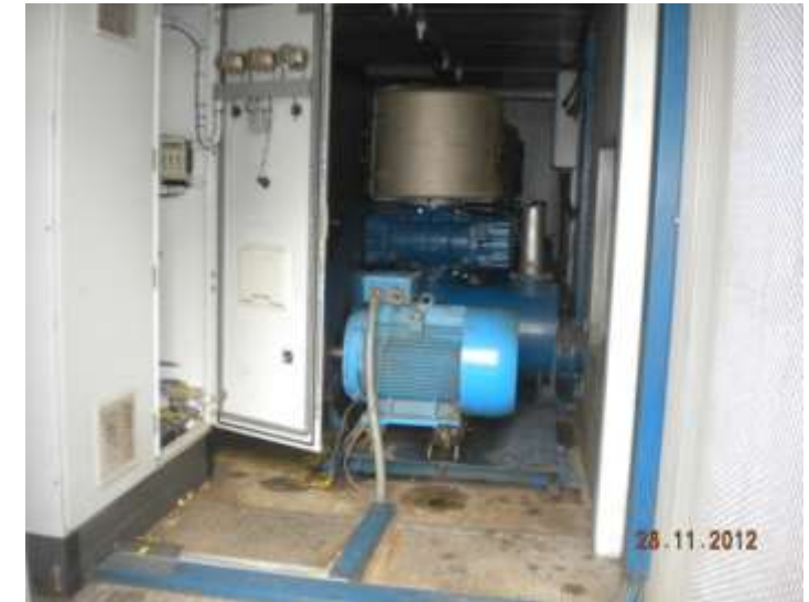
Slika: Stari kontejner sa duvaljkama za aeraciju
