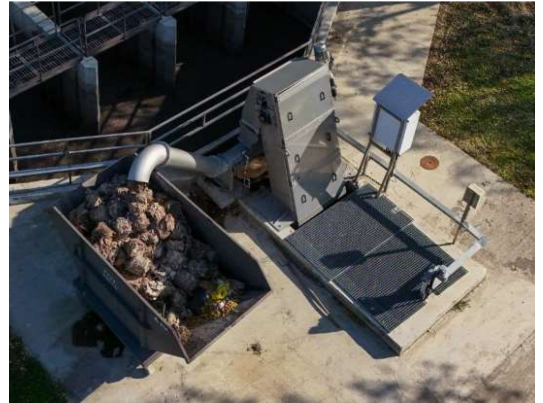
Slika: Presa sa kontejnerom kod grube rešetke
