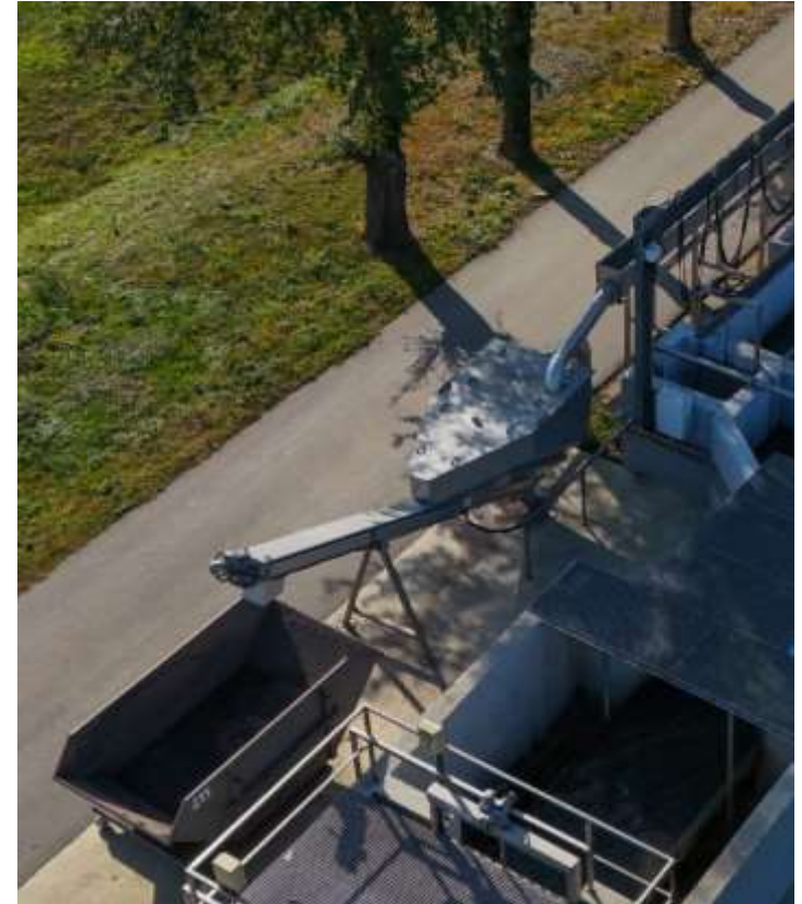
Slika: Seperator peska sa kontejnerom
