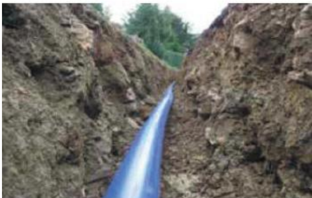
Slika 8. Instalacija HDPE_RC cevi u rov bez posteljice
