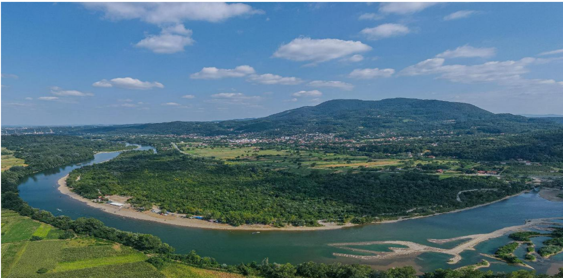
JP "Vodovod i kanalizacija" Loznica
