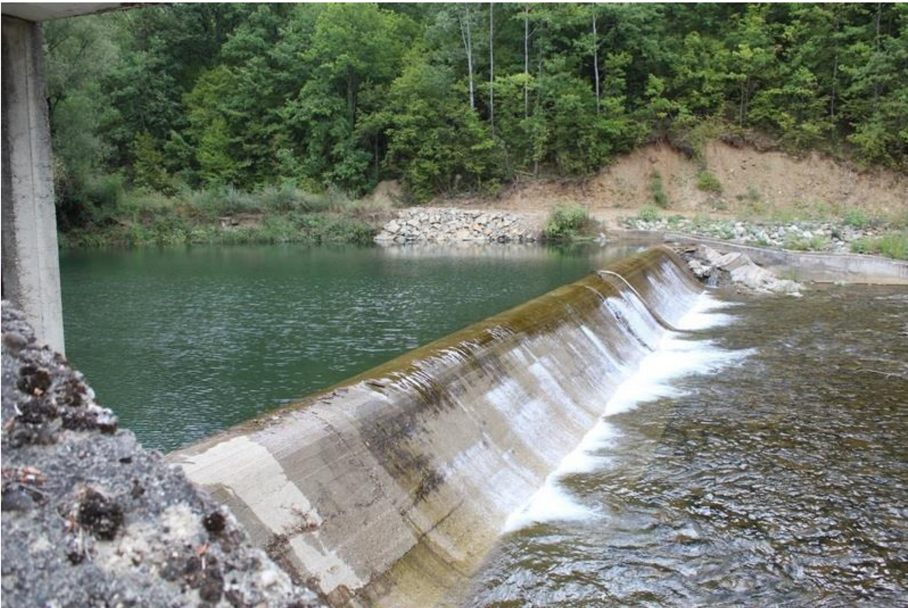
Водозахват на реци Власини – преливни праг, 6. септембар 2021.
