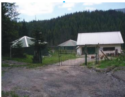
Slika 1: Staro postrojenje pre rekonstrukcije Figure 1: Old plant before reconstruction
